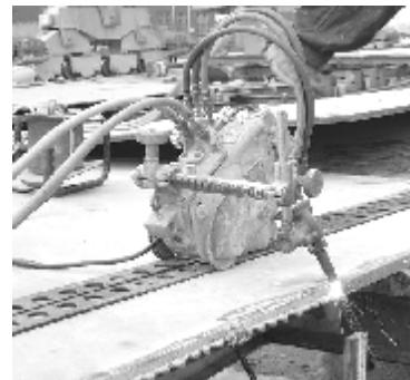
Vát mép bằng máy cắt bán tự động
